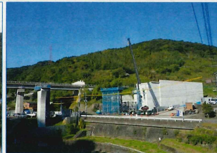
③現川橋付近状況写真
