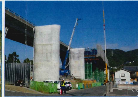
④平間橋付近状況写真
