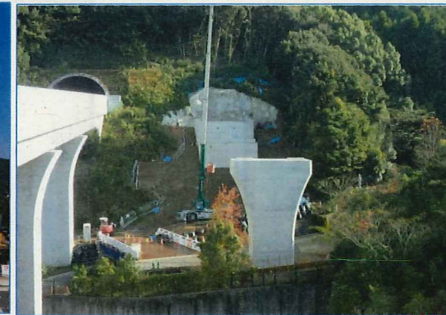
⑤清水川橋付近状況写真
