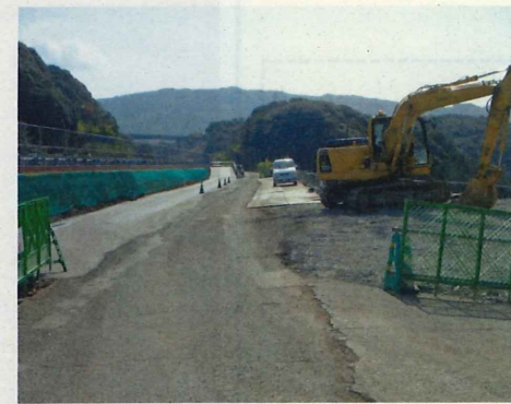
④上り線側 新開口部
