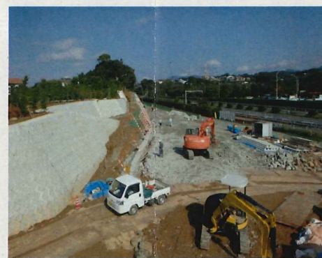
③上り線側 旧高速BS状況写真
