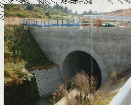
⑩荒川 アーチカルバートウイング部写真
