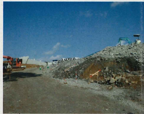
①側道隣接の盛土場 状況写真
