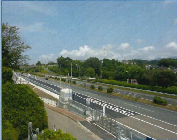
写真② 上り線高速BS(仮設)
