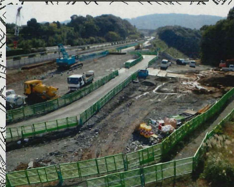
B:側道と本線(上り線)状況写真
