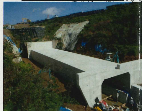
A:河川下流部 カルバート状況写
