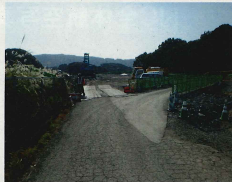
②上り線側 側道状況写真
