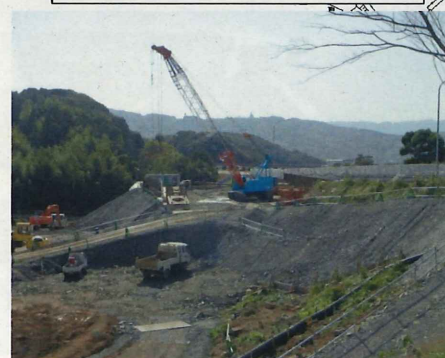
⑧長崎道 C1ランプ側盛土施工 全
