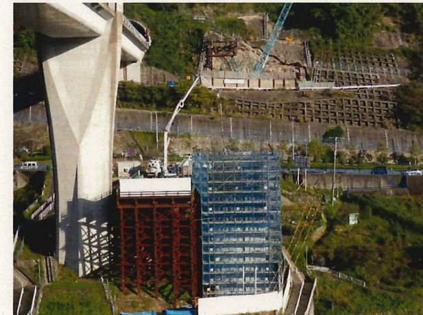
■日見夢大橋P2橋脚
