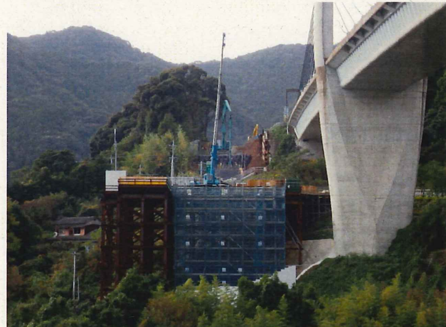
■日見夢大橋P1橋脚
