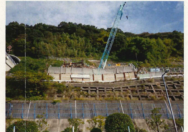
■日見夢大橋A2橋台
