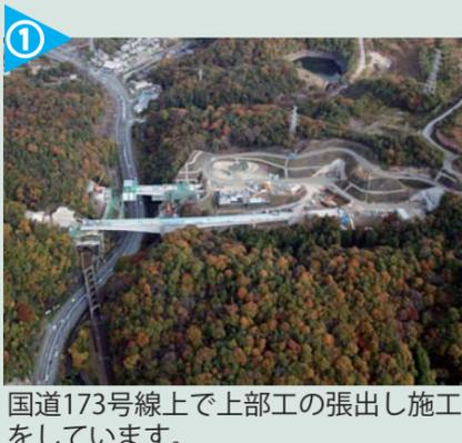
国道173号線上で上部工の張出し施工をしています。
