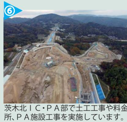
茨木北IC・PA部で土工事や料金所、PA施設工事を実施しています。
