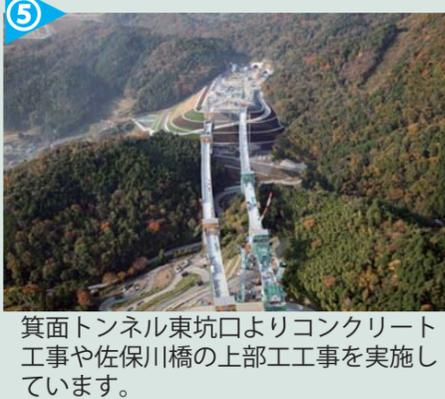
箕面トンネル東坑口よりコンクリート工事や佐保川橋の上部工工事を実施しています。
