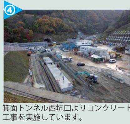
箕面トンネル西坑口よりコンクリート工事を実施しています。
