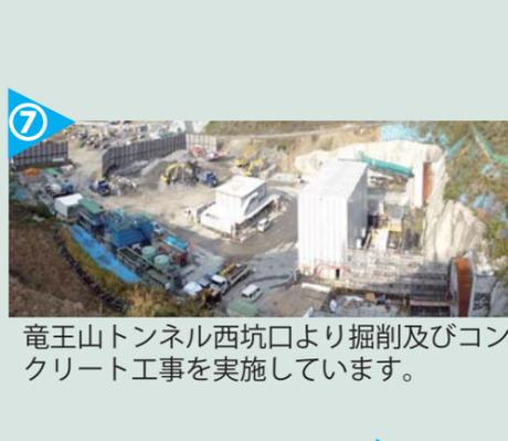
竜王山トンネル西坑口より掘削及びコンクリート工事を実施しています。
