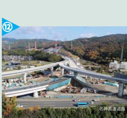
上部工工事の床版工事と遮音壁工事を実施しています。
