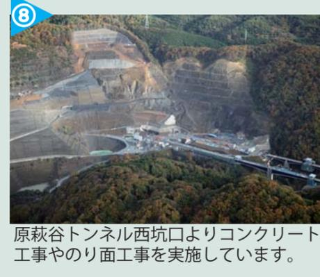
原萩谷トンネル西坑口よりコンクリート工事やのり面工事を実施しています。
