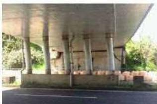
＜東原橋(熊本ICランプ橋)の傾いた橋脚＞
