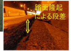
路面隆起により発生したひび割れ
