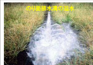
のり面排水溝の溢水
