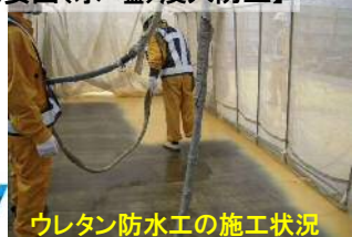
ウレタン防水工の施工状況
