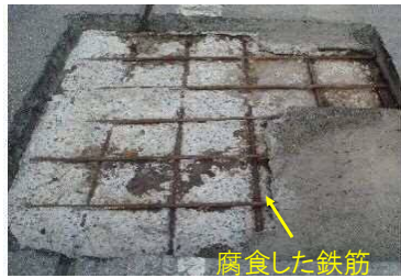
舗装撤去後の床版上面
