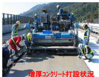
増厚コンクリート打設状況
