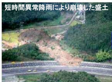
短時間異常降雨により崩壊した盛土
