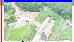
②E2 山陽道 志和トンネル
