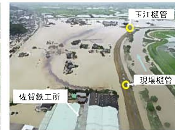
④【佐賀県】六角川の油流出状況
