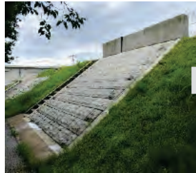
試験堤防の三次元データをiPhoneのLiDARにより計測し収集
